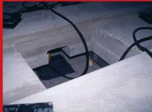
Auflagen der Stahl- betonplatten (Massen) auf Elastomer- Blocklagern
