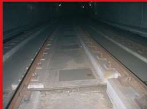
Fertiges Masse-Feder- System mit Schienen im Stadtbahn- tunnel
