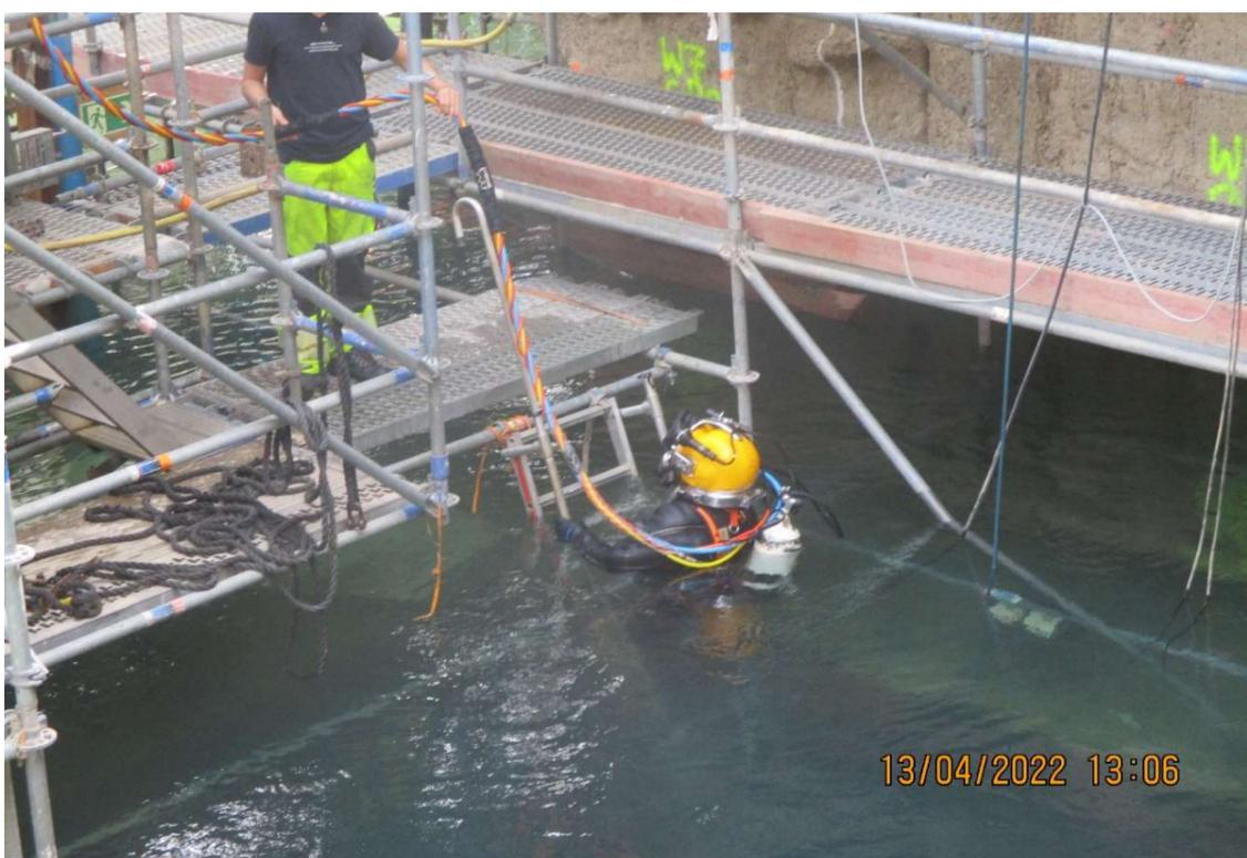
Wegen des hohen Rheinwasserstandes müssen die im Gleiswechselbauwerk tätigen Taucher derzeit über eine am Baugerüst montierte Leiter in die Öffnung der Betondecke einsteigen, um in die darunterliegenden Ebenen des Bauwerks gelangen und dort die notwendigen Arbeiten ausführen zu können.
