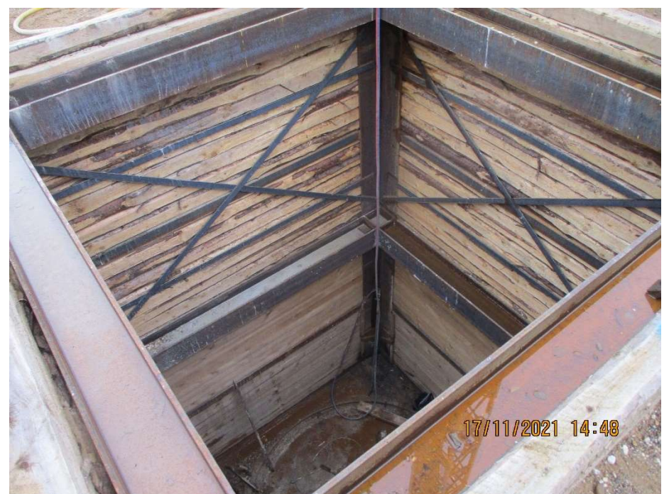
Blick in die Baugrube, die nun verfüllt wird
