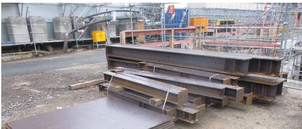
Konstruktionsstahl für die Verschließung der Tunnelröhren
